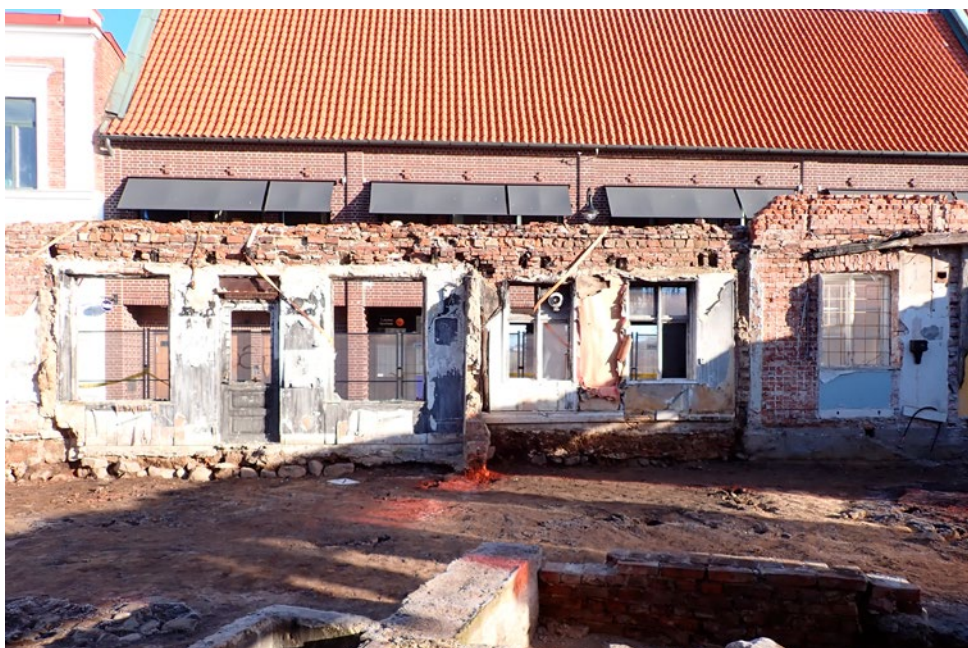
Figur 17. Den östra halvan av Byggnad 2 kvarstående väggar inklusive övergången till Byggnad 1. I bilden kan skillnader i tegelväggarna och socklarna ses längst till vänster om det sista fönstret i fotografiet och där de två byggnaderna möts, det vill säga mellan de två fönstren i den högra delen av fotografiet. De två fönster direkt till vänster om den punkt där de två byggnaderna möts ansågs som typiska för 1800-talet vid den byggnadsantikvariska undersökningen 2022 medan de övriga fönstren och dörren ansågs som typiska för tidigt 1900-tal. Foto: Johan Klange. (fotonummer: 2025-65-77) mot nordnordost.
