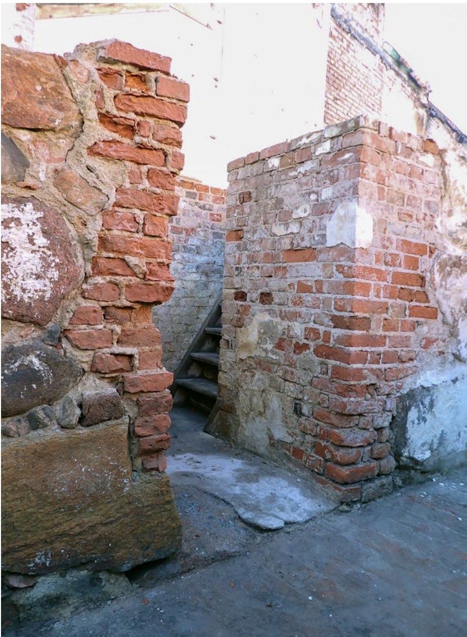
Figur 16. Detaljfoto av in- gången till källaren som visar att teglet i dessa i delar utgörs av mycket mer slitet tegel, vilket skulle kunna tyda på att väggarna vid något tillfälle byggts om. Foto: Johan Klange. (fotonummer: 2025-65-143). Mot söder.
