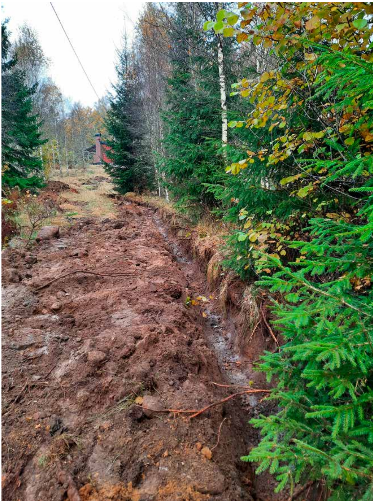
Figur 5. Översikt av schakt OS200 södra del. Mot norr. Foto: Jonas Carlsson. (Fotonr. 2024-85-2).
