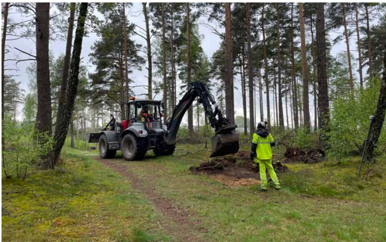
Figur 4. Jonas övervakar schaktningsarbetet vid schakt 200, i norra änden av utredningsområdet. Den äldre gångstigen, som korsar den sandiga höjden vid Gråberg, löpte här längs med utredningsområdet. Foto mot väst (Fotonr: 2024-43_1). Fotograf: Linda Wigert
