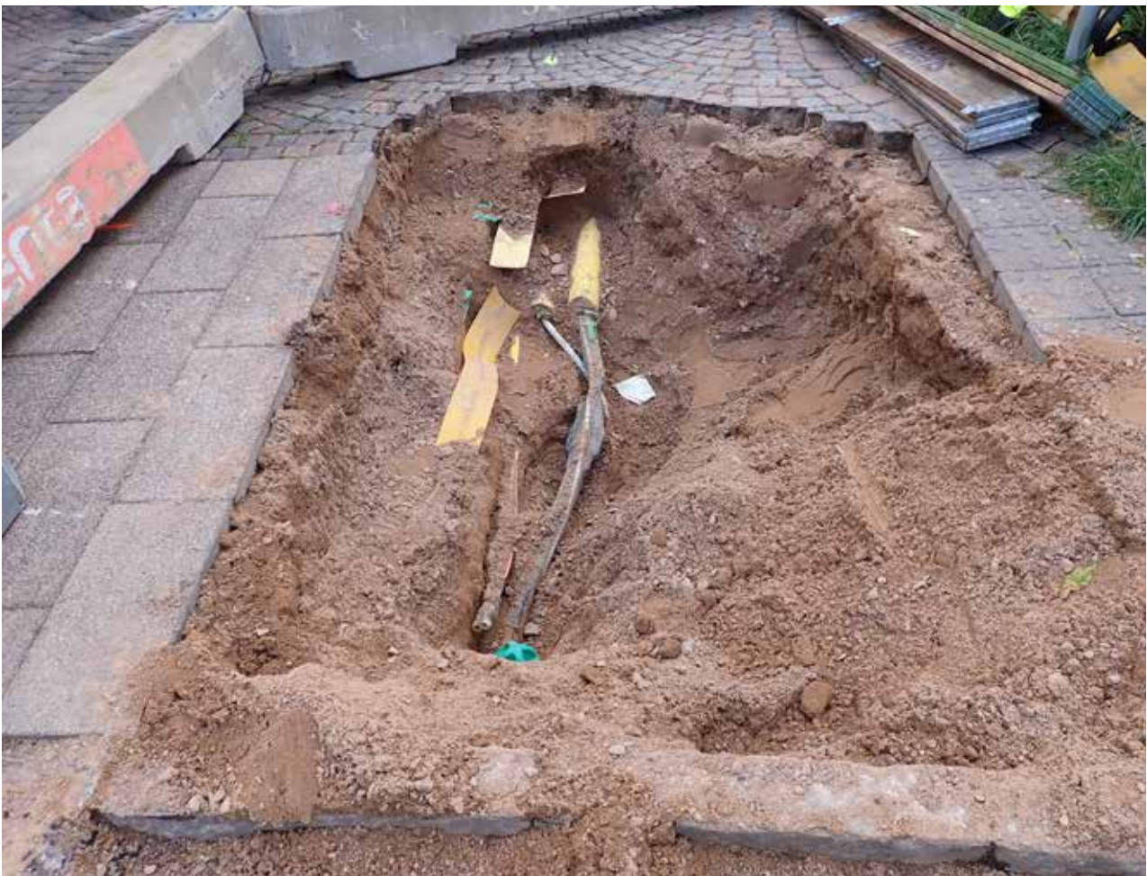
Figur 3. Översikt på OS1000 och den trasiga elkabeln som går in på Hantverksgatan. Schaktet öppnades i korsningen Hantverksgatan/Bryggaregatan. Mot söder. (Fotonr. 2024-87:1). Foto: Johanna Olsson.
