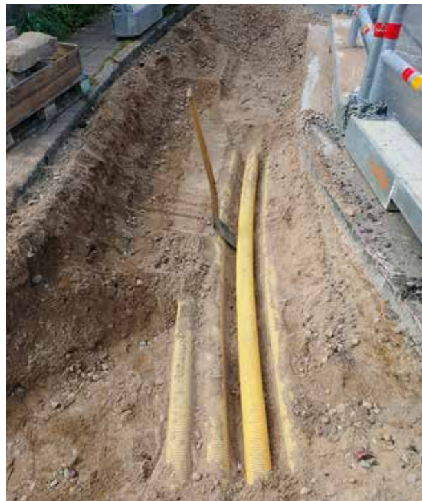
Figur 5. Översikt på den del av OS1000 som placerades på Bryggaregatan. Skyffeln indikerar vilket elrör med elkabel som ska skarvas samman med den trasiga kabeln. Schaktet öppnades i korsningen Hantverksgatan/Bryggaregatan. Mot väster. (Fotonr. 2024-87:3). Foto: Johanna Olsson.
