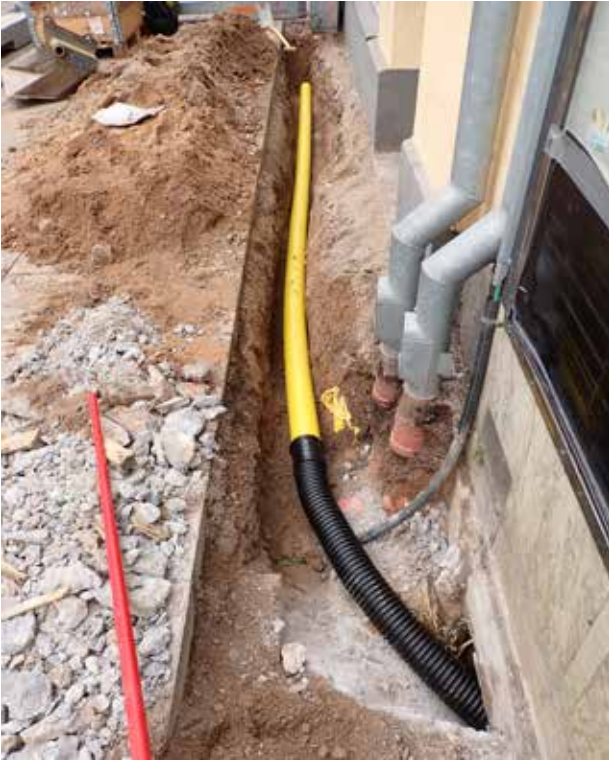
Figur 6. Översikt på OS1002 utanför Brogatan 24 & 26. Elröret går in i Brogatan 24 källare. Mot väster. (Fotonr. 2024-87:4). Foto: Johanna Olsson.
