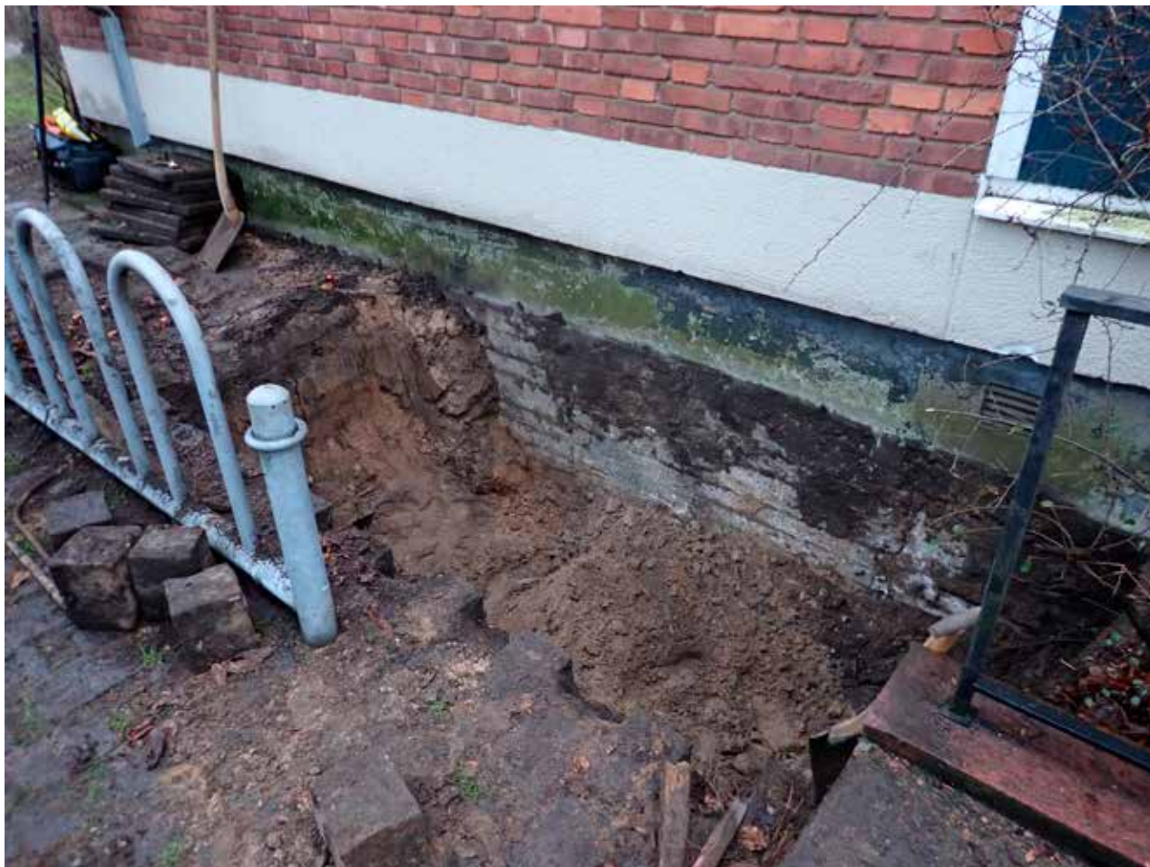
Figur 5: Översiktligt foto av schaktet. Mot SO. Foto: 2023-006:5, Sofie Renström.
