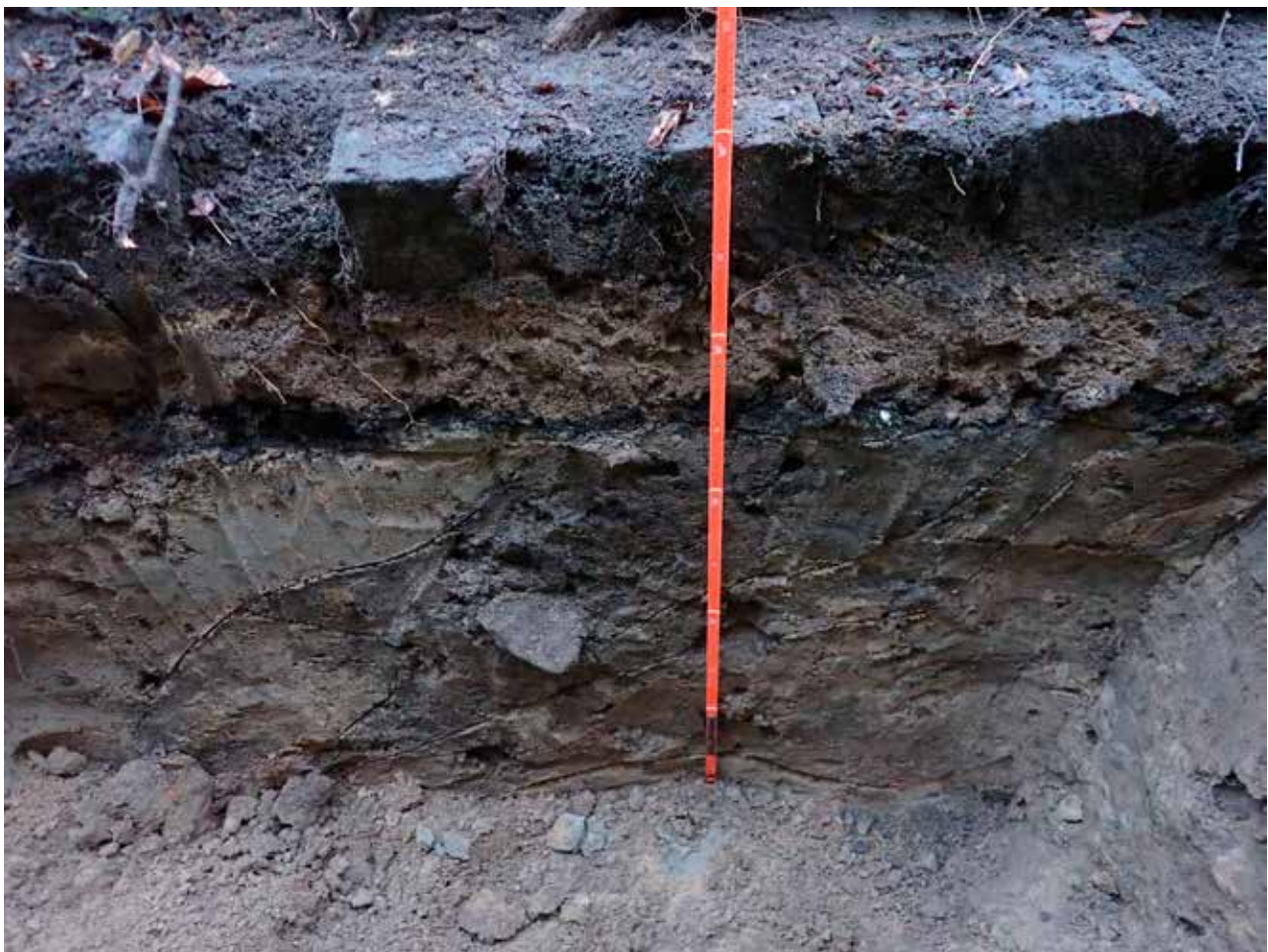
Figur 6: Den norra schaktväggen där sluttande lager av omrörda utfyllnadsmassor är synliga under dagens markbeläggning. Mot N. Foto: 2023-006:2, Sofie Renström
