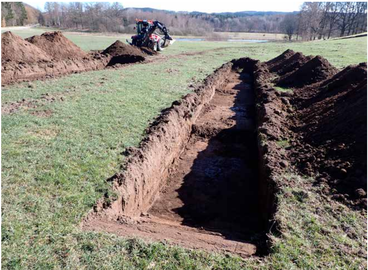
Figur 6. Översikt schakt 206 samt lager där i. Foto mot nordöst. Foto: 2023-103-1, Jonas Carlsson.
