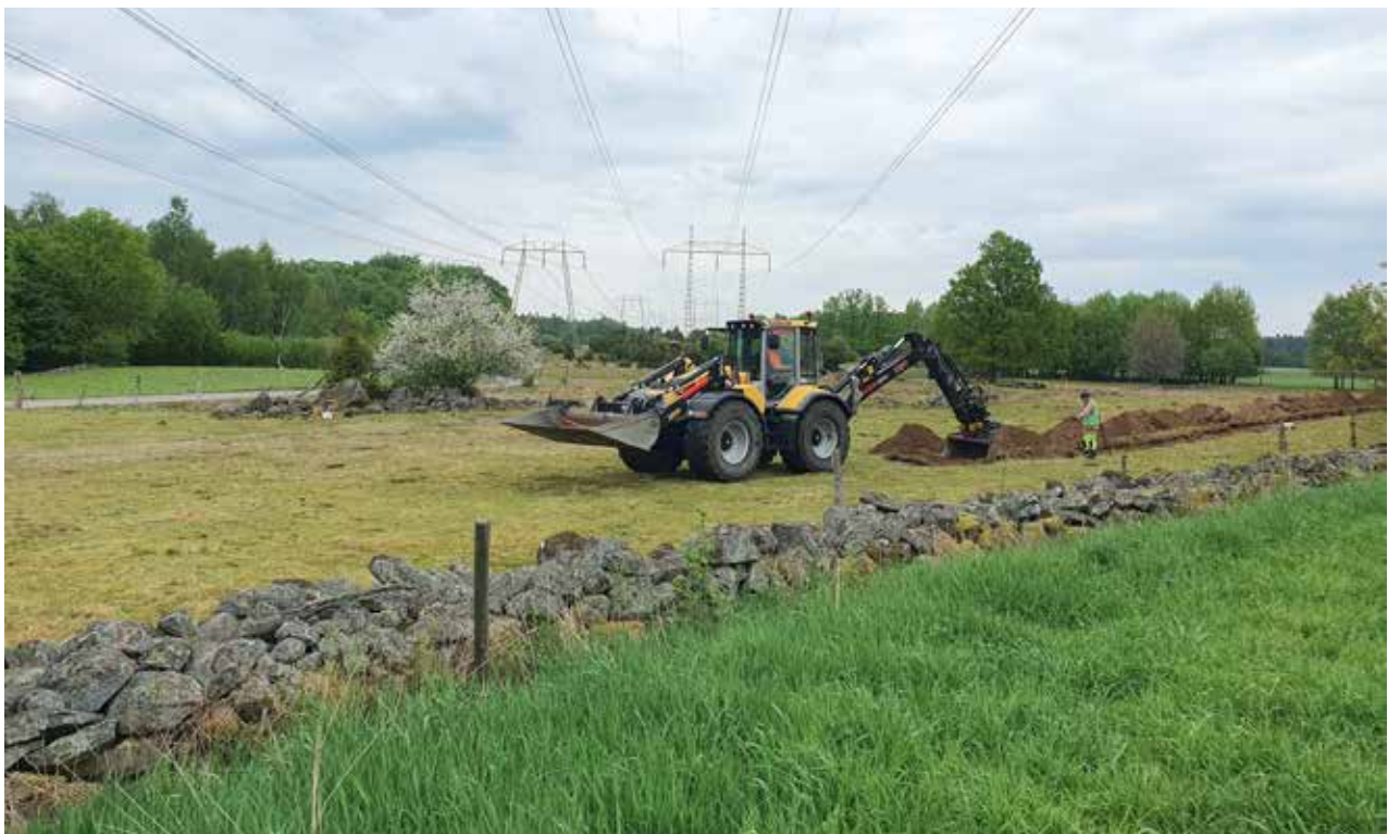
Figur 22. Pågående grävning av S 219 fotograferad mot NO. (foto: Carl Persson)
