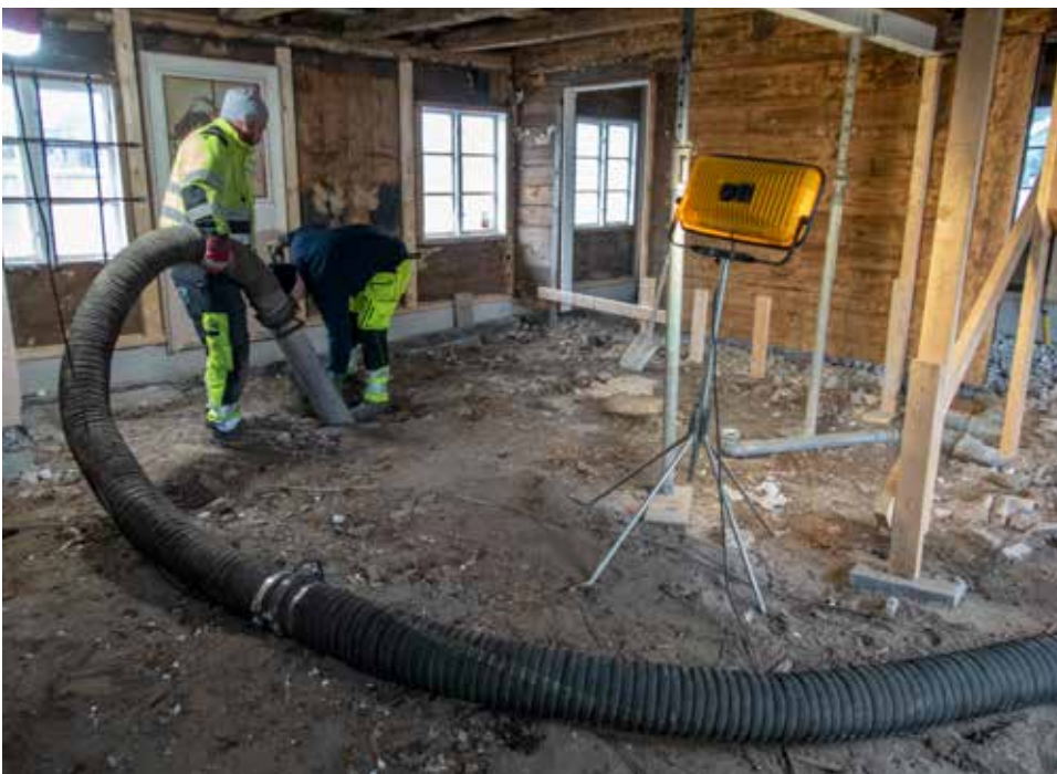
Figur 3: Jorden grävdes lös i spadstick som sedan sögs upp. Fotonr: 2022-24:1 Foto: Sofie Renström.
