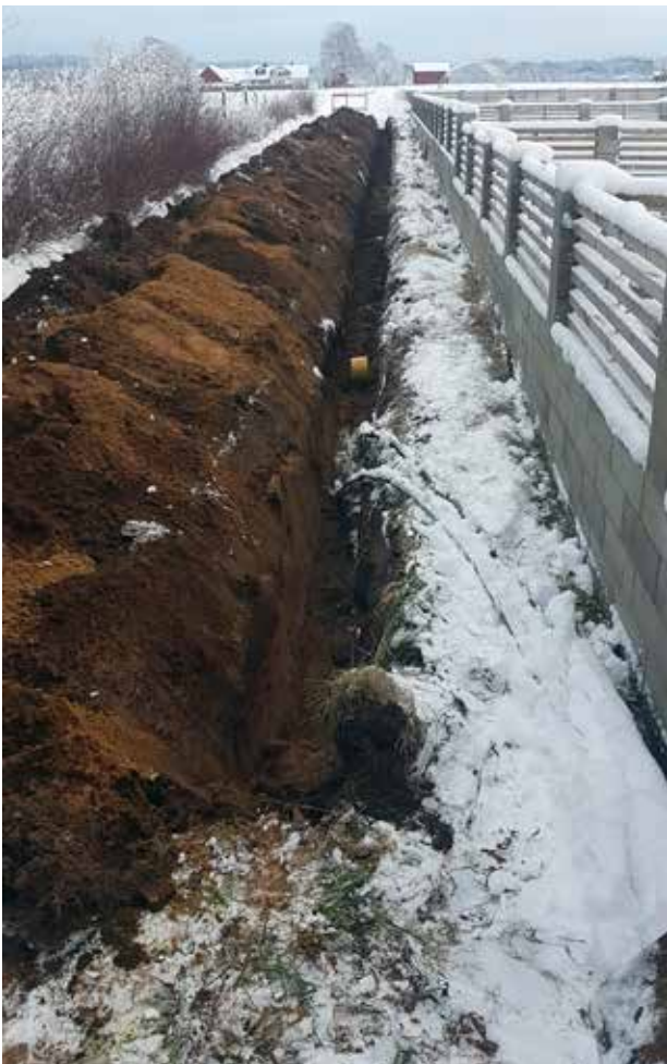
Fig 3. Ledningsschaktets östra del mot öst. Foto: Mats Nilsson. (Fotonr: 2023-11-1).
