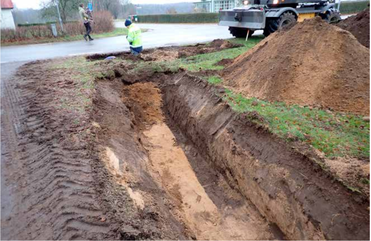
Fig 7. Ledningsschaktets västra del mot Brödåkravägen med rester av igenfyllt VA-schakt synligt i schaktets botten. Mot väst. Foto: Mats Nilsson. (Fotonr 2023-11-9).
