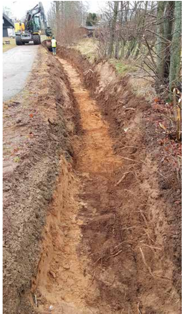
Fig 4. Ledningsschaktets centrala del med den norra delen av fornlämning L1996:7100 till höger, mot väst. Observera träd och buskar till höger i bild som gör att marken är påverkad av rötter. Foto: Mats Nilsson. (Fotonr 2023-11-2).
