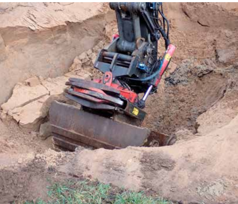
Figur 7. Schakt 702 mot sydöst. Viss laminering av organiska vindsediment kan ses i schaktkanten. Översandningslager 2,5 meter. Torvlagret 0,3–0,4 meter. Under torvlagret övergick sanden till postglacial lera. Djup 2,9 meter. (Foto 2023-32-13). Foto: Mats Nilsson.
