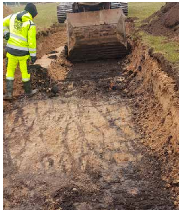
Figur 6. Schakt 497 mot öst. Matjord 0,3 meter. Översandningslager 0,2 meter ovan torvlager 0,2 meter tjockt. Årderspår synliga under torvlagret på ett djup av 0,75 meter. Torvlagret daterat till tiden mellan 1491 och 1647 efter Kristus. (Foto 2023–32–8). Foto: Mats Nilsson.
