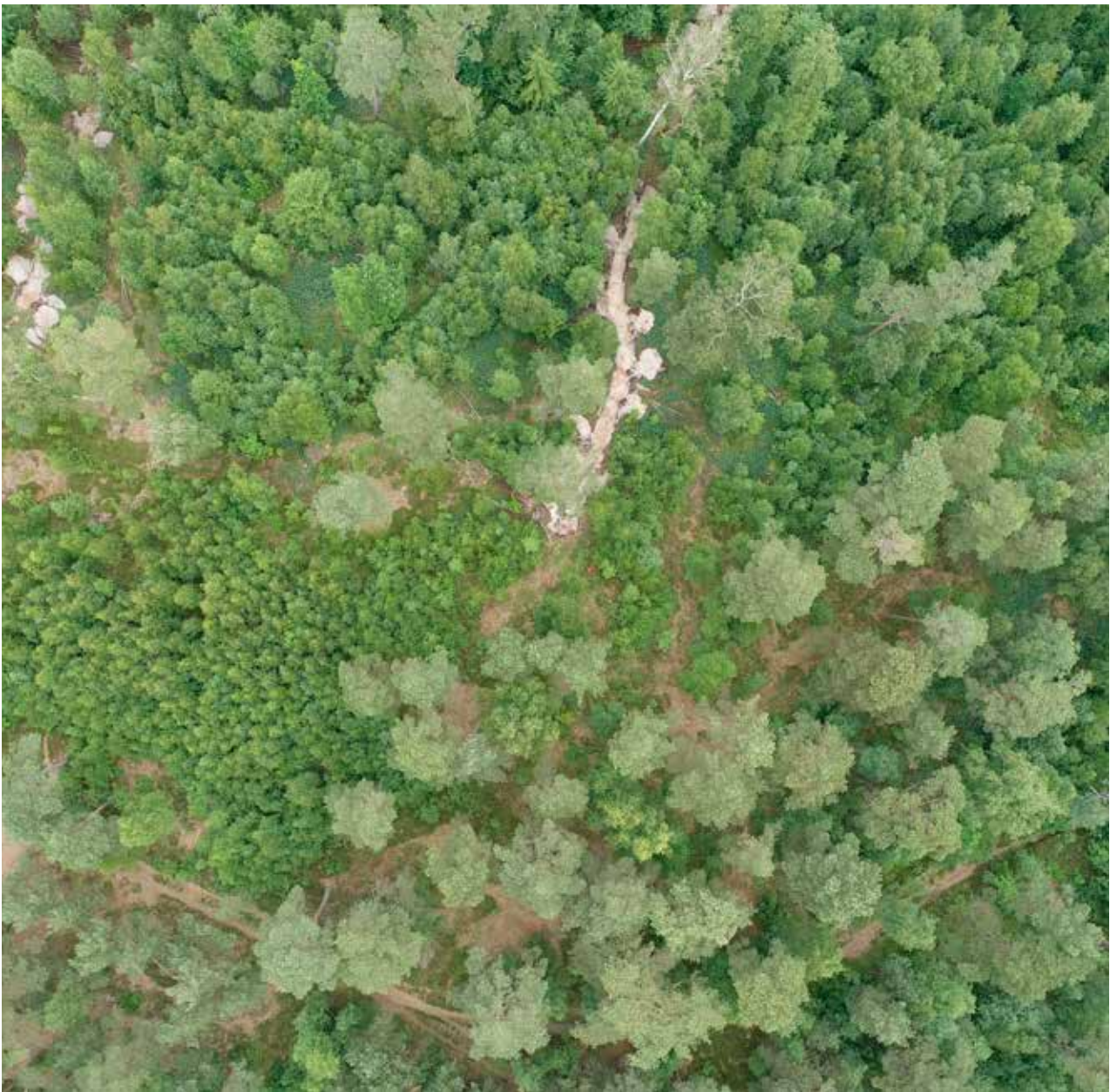
Figur 6. Drönarfoto av igenläggning av schakt. Schakt 268. Foto: Patrik Hallberg. (Fotonr. 2024-18-05).
