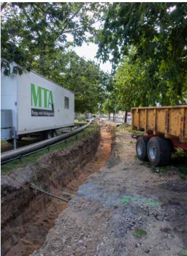
Figur 11. Översikt av delsträcka av schaktet fotat mot väst. Till vänster utanför bild ligger Norre Katts park, i schaktväggen syns moderna bärlager, bevarade kulturlager och sedimenterade sandlager. Fotograf: Sofie Renström. Fotonummer: 2022-069:20.
