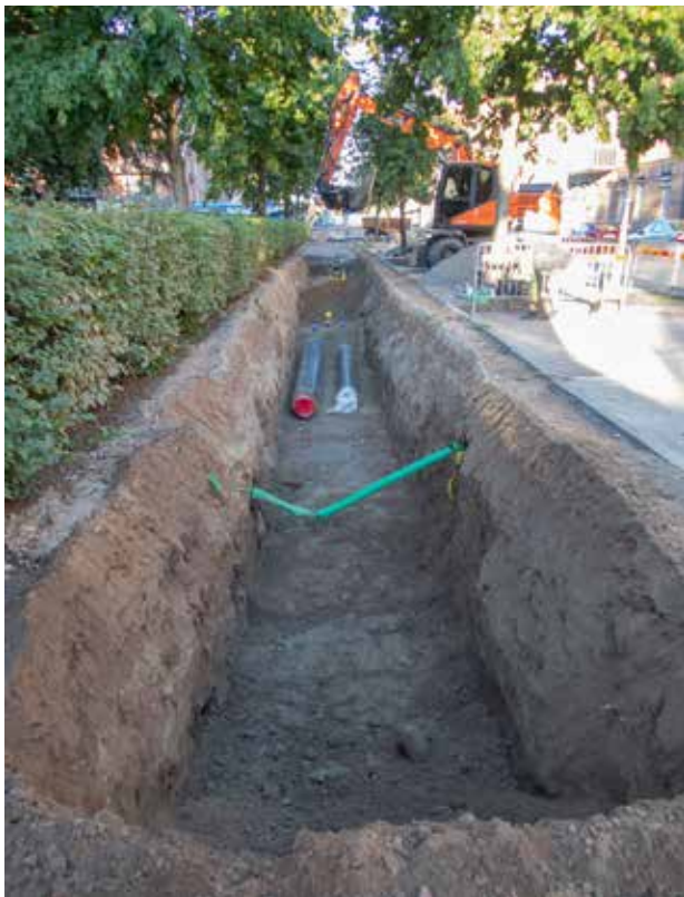
Figur 5. I bakgrunden syns en igenlagd del av schaktet varur fjärrkylalledningarna sträcker sig i den nyöppnade schaktsträckan. Mot väst. Foto: Sofie Renström. Fotonummer: 2022-069:6.
