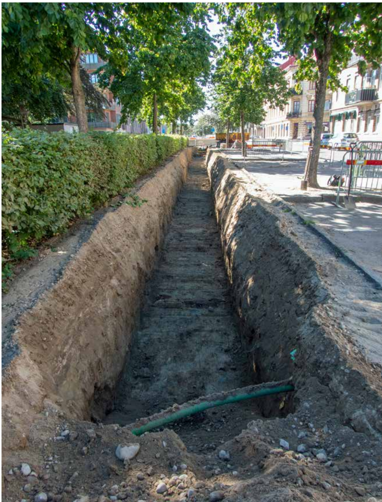
Figur 9. Den arkeologiska övervakningen påbörjades i undersökningsområdets västra del närmast Norra Vägen. Här syns första sträckan av schaktet grävd till botten. Massorna var i denna del blandade, recenta utfyllnadslager. Mot väst. Foto: Sofie Renström. Fotonummer: 2022-069:5
